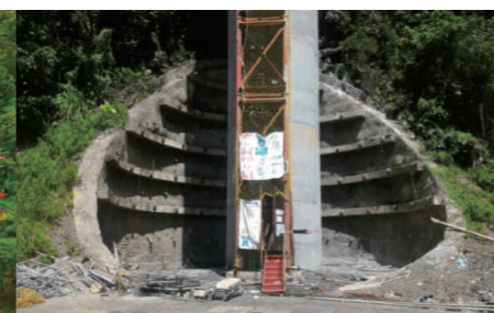
竹削工法於橋墩施作
