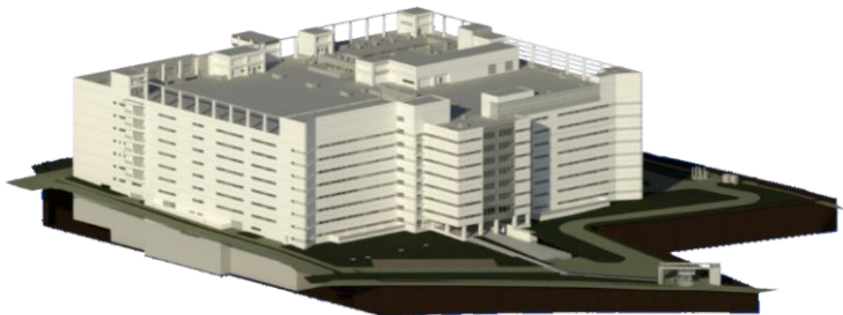
大立光電子廠房新建工程
