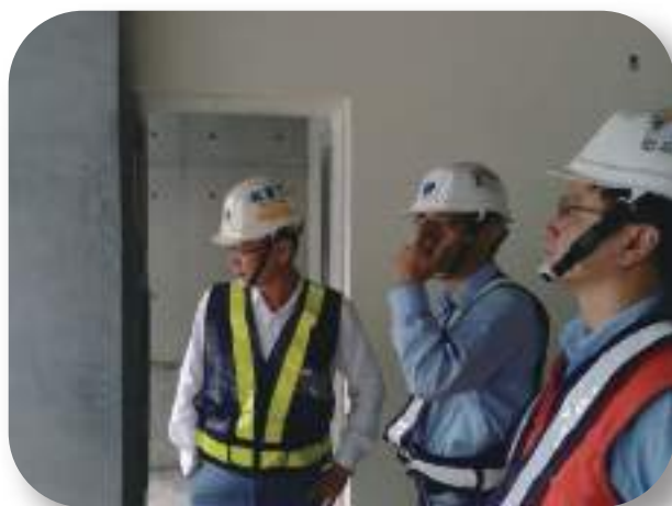
黃總經理巡視臺東臺九線土木工程
