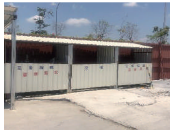
氧氣乙炔鋼瓶放置區
