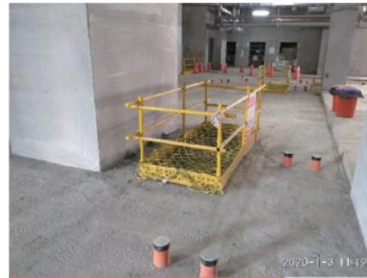
開口設置護欄併安全網
