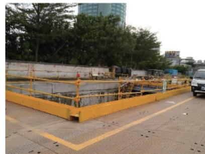
導溝開口設置護欄及鋼網防墜
