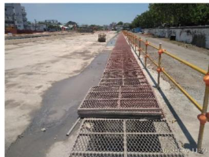
導溝開口設置護欄及鋼網防墜
