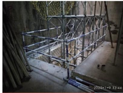
結構透空處設置施工架防墜
