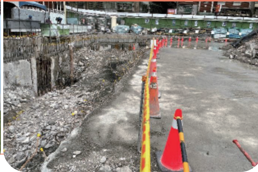
施工作業區區隔警示線
