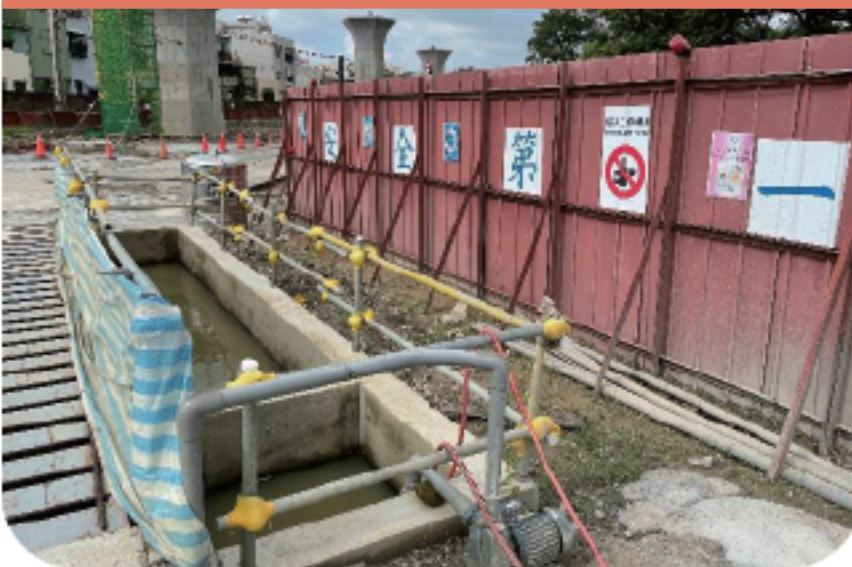
工區出入口設置洗車台及沉澱池
