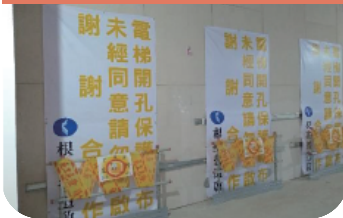
電梯井裝設護欄及全遮斷防護
