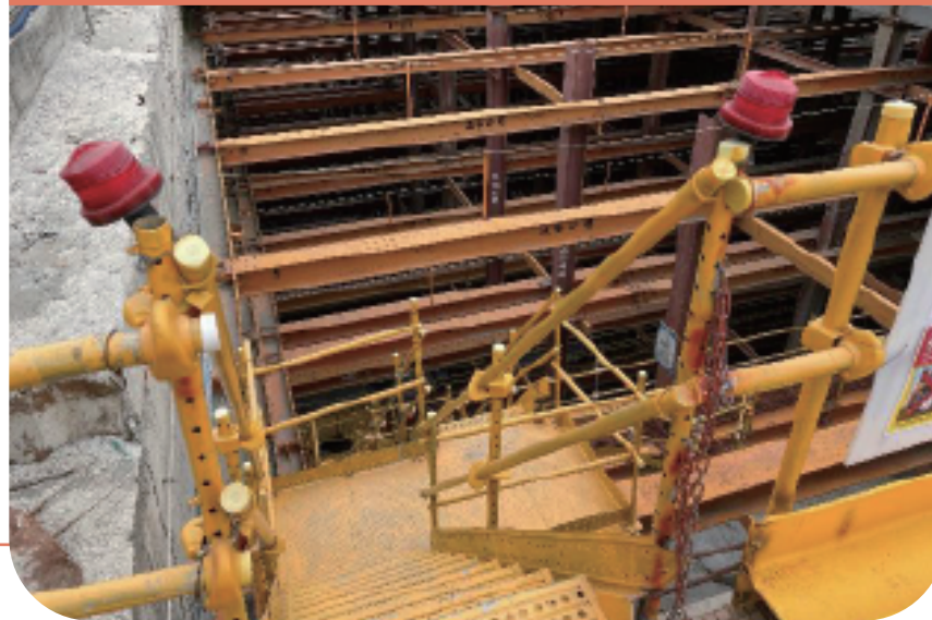
施工作業區設置安全上下設備
