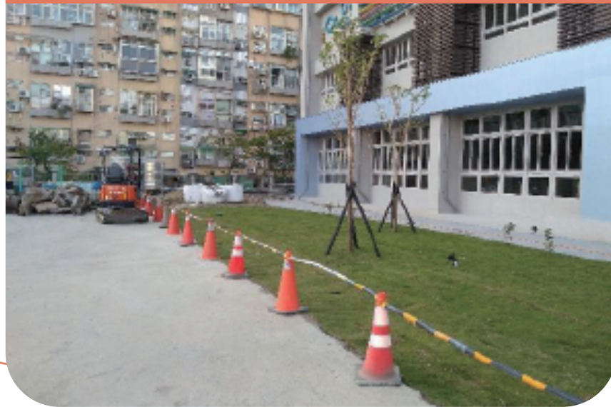
施工作業區區隔警示線
