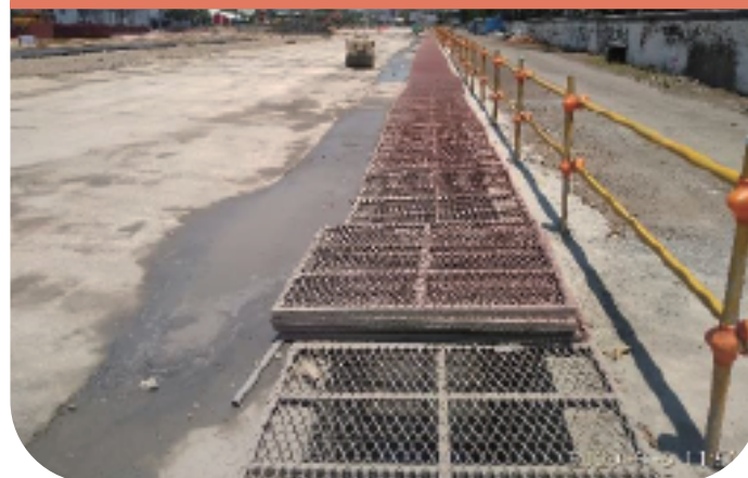
導溝開口設置護欄及鋼網防墜
