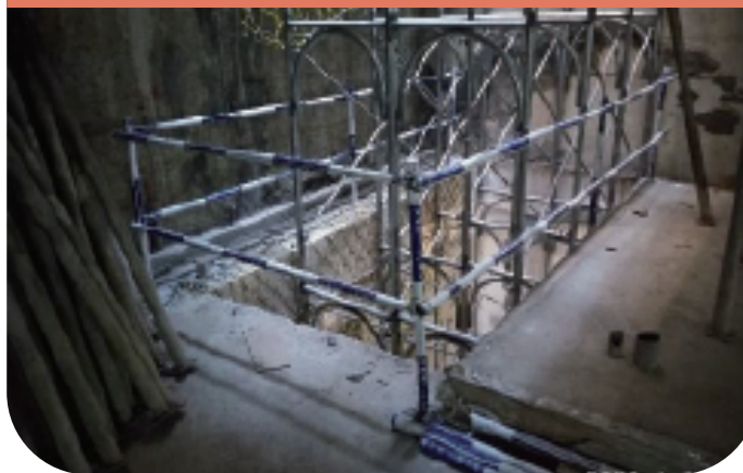
結構透空處設置施工架防墜
