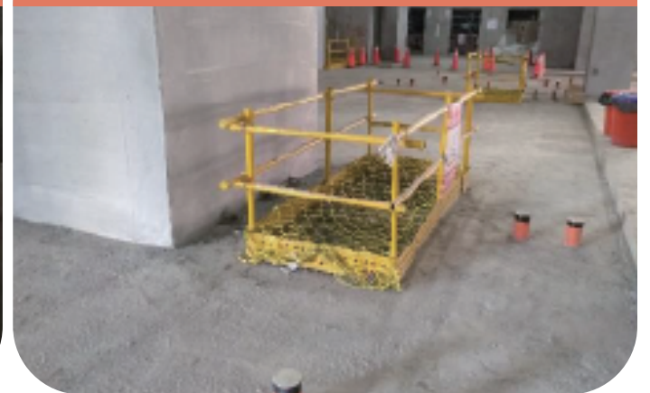
開口設置護欄併安全網
