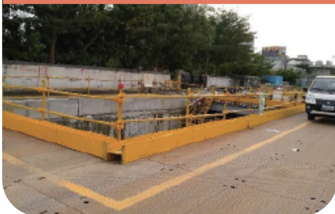
導溝開口設置護欄及鋼網防墜
