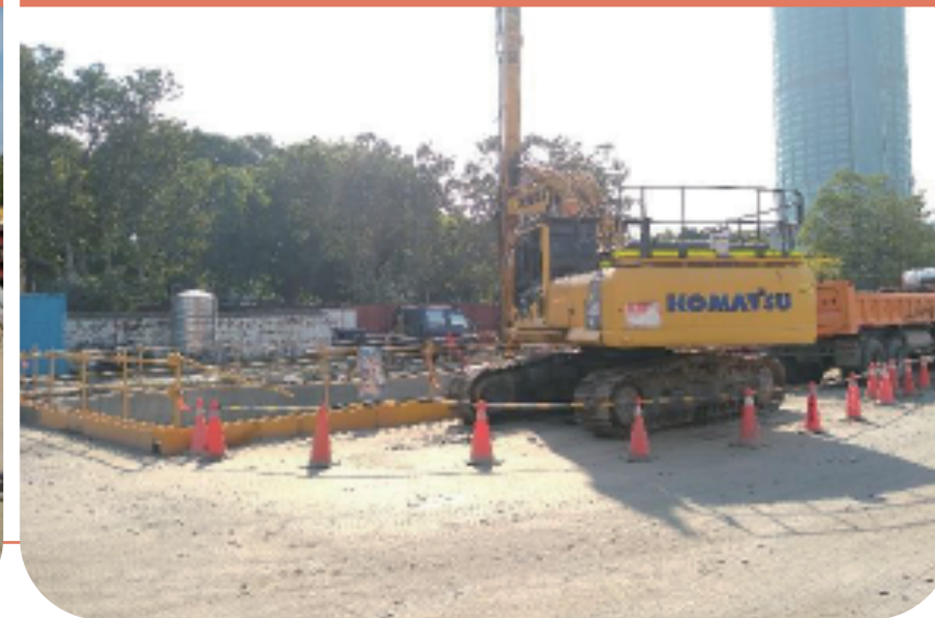
施工機具作業區(迴轉半徑)圍管施
