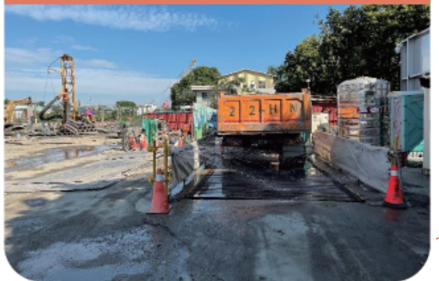
工區出入口設置洗車台及沉澱池
