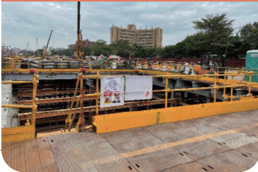
施工作業區設置安全上下設備
