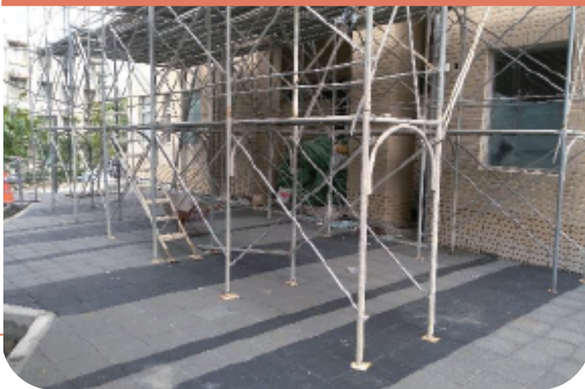
施工架交叉拉桿、下拉桿及上下設備裝設
