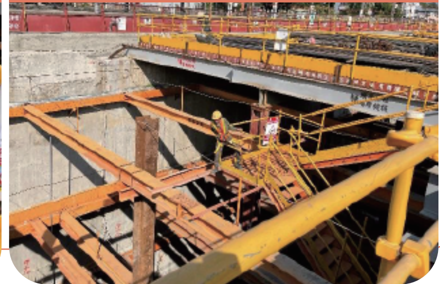
施工作業區設置安全上下設備
