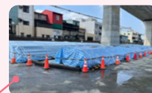
規劃專區分類堆置及區隔圍管
