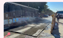
工區出入口設置洗車台及沉澱池
