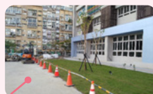
施工作業區區隔警示線
