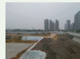
裸露土石覆蓋黑網
