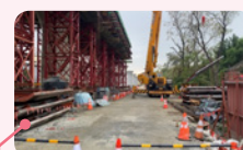
施工機具作業區(迴轉半徑)圍管
