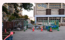
物料堆置區區隔及警示線
