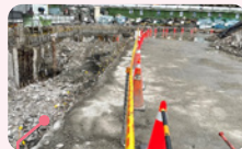
施工作業區區隔警示線
