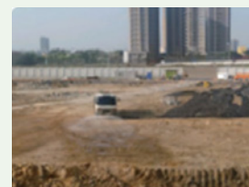
工區內灑水及抑制揚塵
