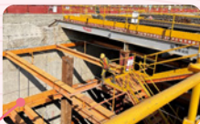
施工作業區設置安全上下設備
