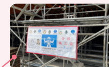
施工架檢查及指派合格作業主管
